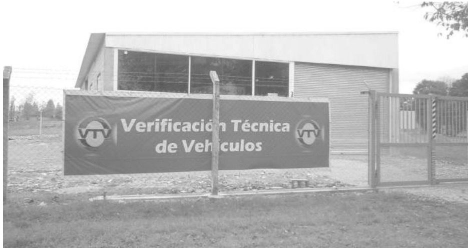
Vista de la planta de verificación ubicada en Mitre al 3800.
