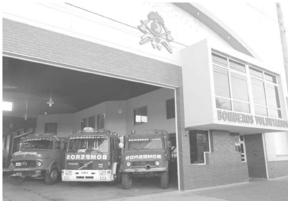
Frente del cuartel de Bomberos ubicado en Avda. Vedia al 400. Fotos De Sogós.
