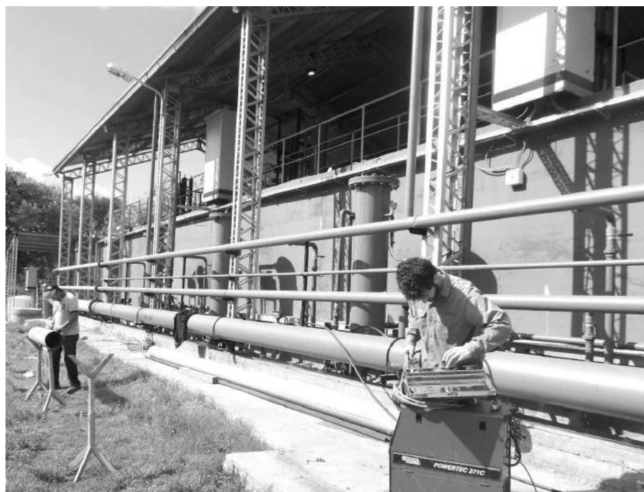
A buen ritmo se trabaja en la planta potabilizadora para su puesta en marcha.
