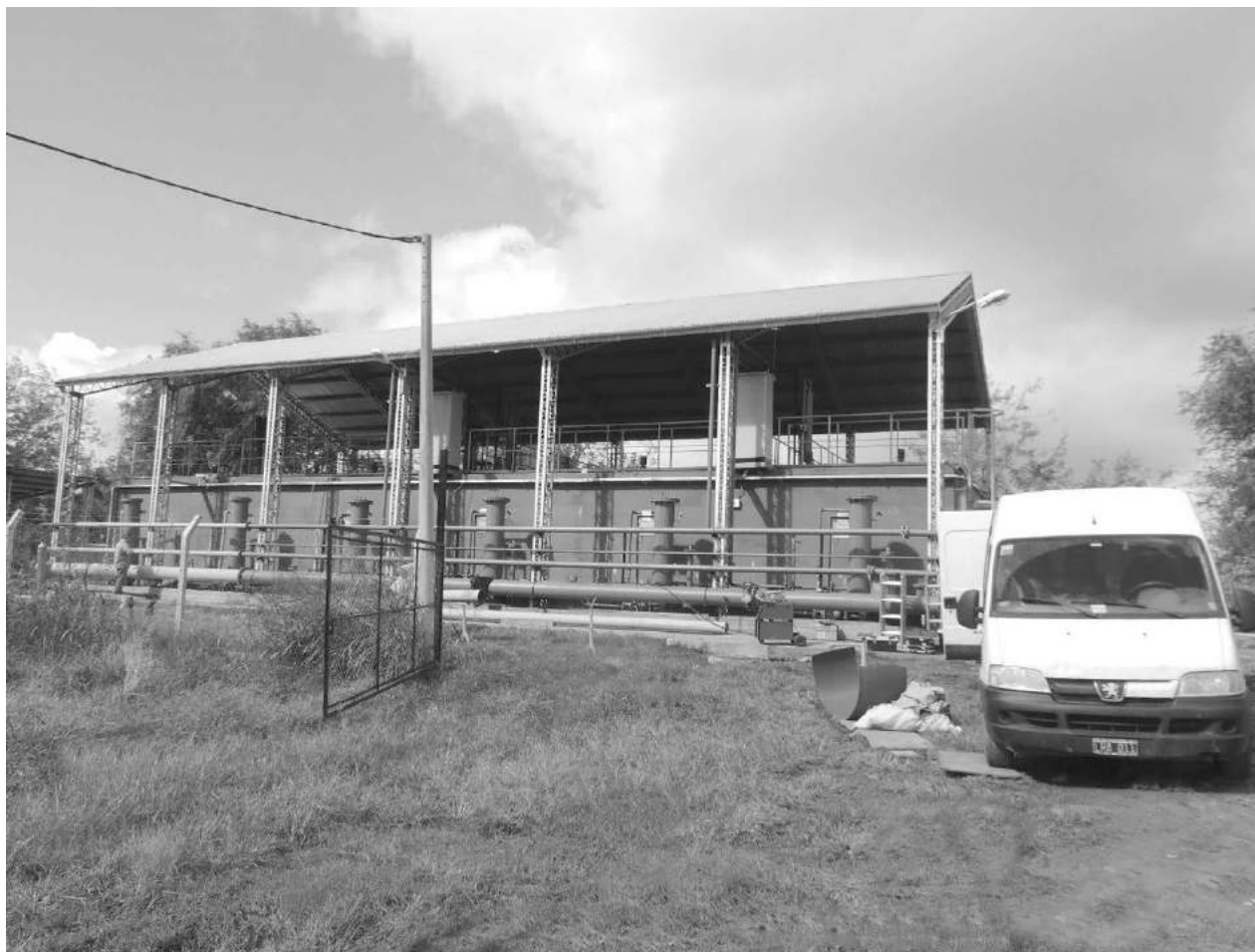
Vista de la planta de tratamiento de ABSA donde se ultiman los trabajos para su puesta en marcha.
