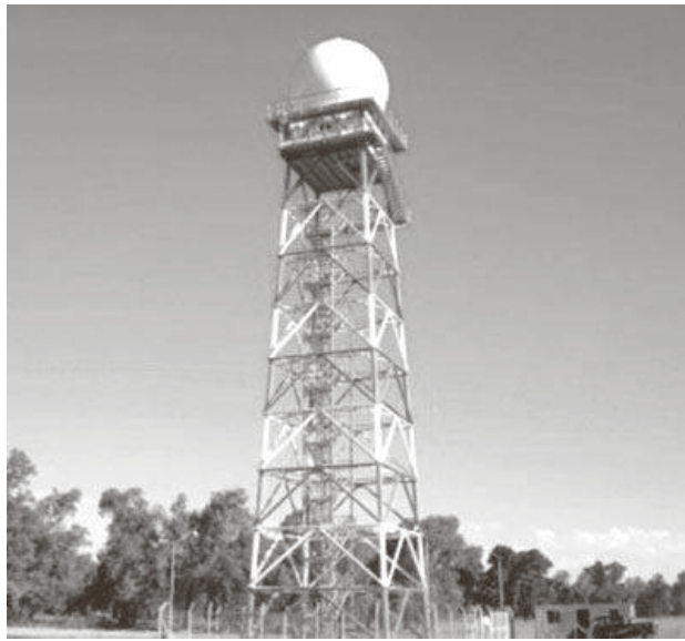
El equipo se emplazó en una estructura de 36 metros de altura. Foto: El Cordillerano/InfoGEI.
