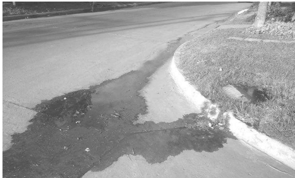
Se puede apreciar en la imagen el derrame del líquido.
