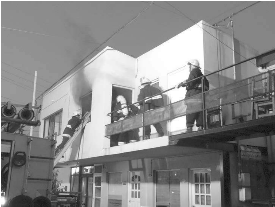
Importantes daños ocasionó el fuego en la vivienda.
