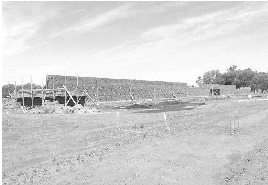
Vista de la importante obra que lleva adelante el club casarenses.
