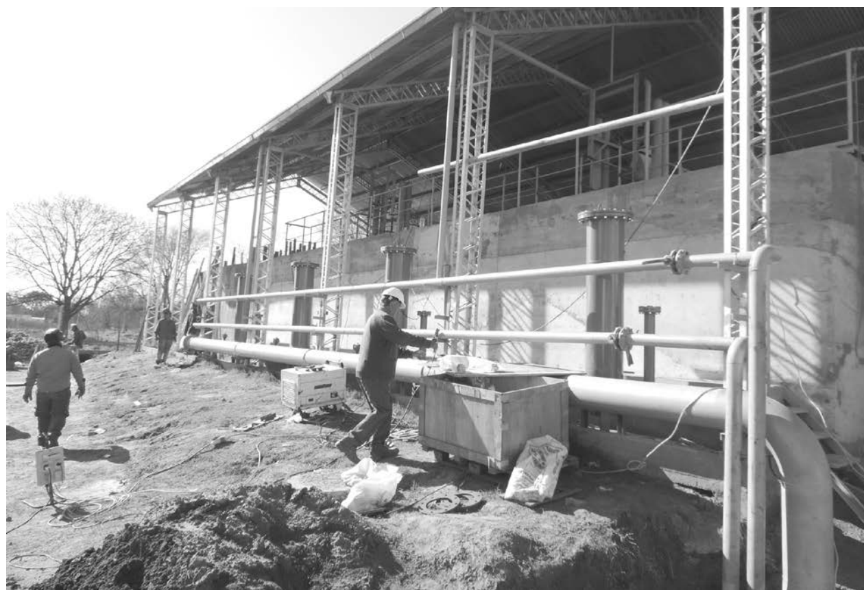
Buen ritmo de obra lleva la planta tan esperada por la comunidad.
