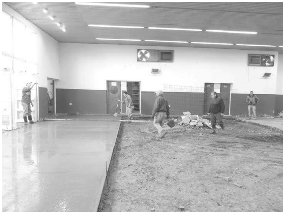
Buen ritmo de obra lleva el piso del salón donde se guardan las unidades del cuartel. Fotos De Sogós.
