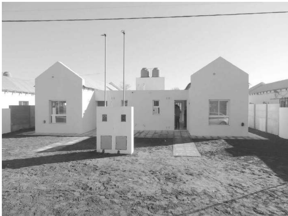
Vista de las viviendas entregadas.
