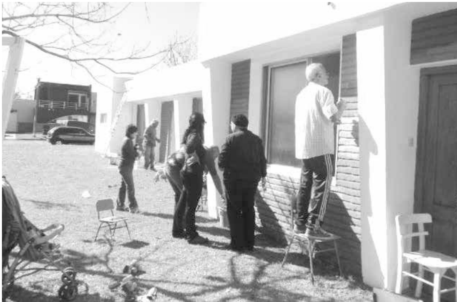
Vista de los trabajos de pintura del Jardín de Infantes 902 de Quiroga.
