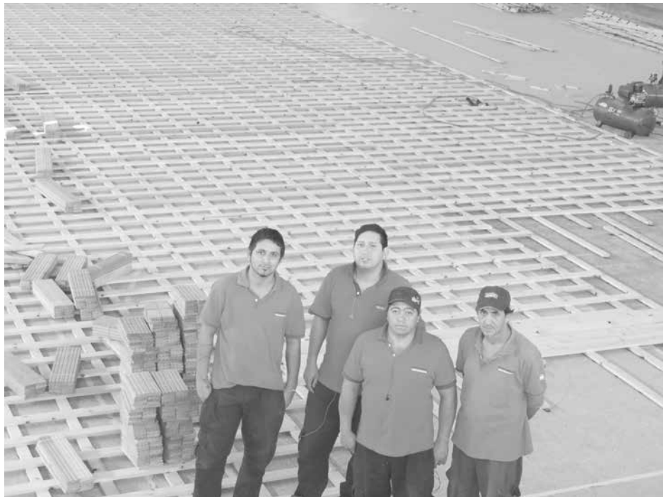
Personal de "Alto Paraná Maderas" trabajando en la colocación del piso.
