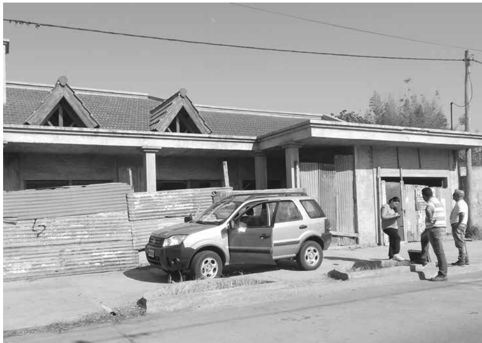
La unidad EcoSport estacionada sobre vereda, en la cual dio aviso un albañil.
