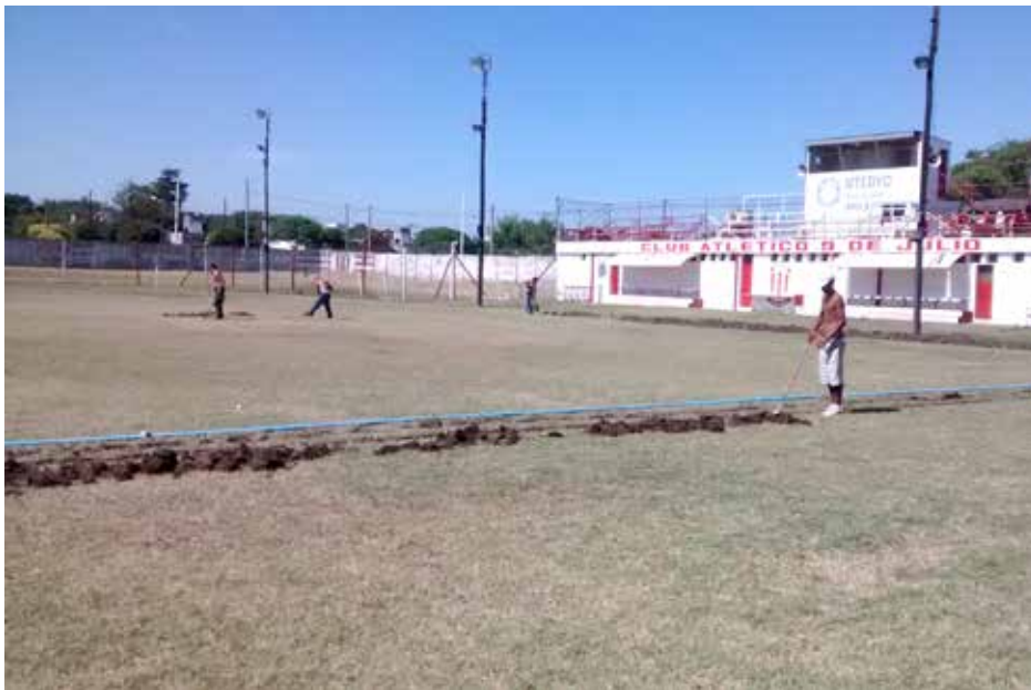
Trabajos realizados para la instalación del nuevo sistema de riego.
