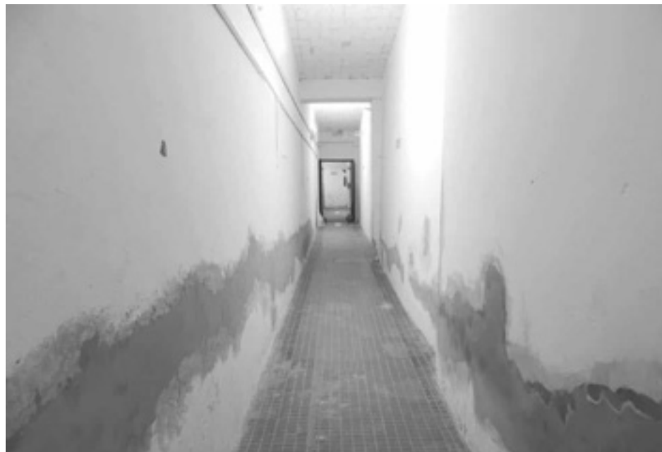
Vista de las refacciones hechas en la galería lateral a la sala. Fotos De Sogos.
