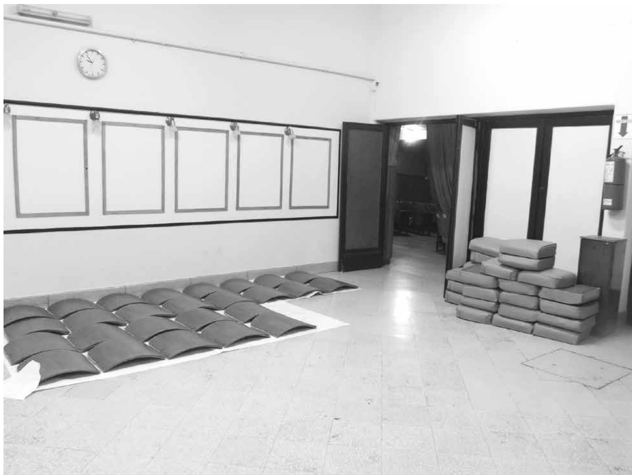
Partes de las butacas reparadas listas para ser instaladas nuevamente.
