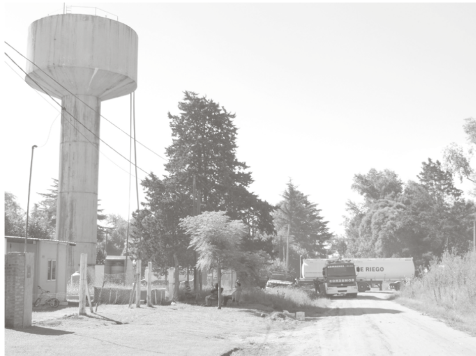
Reposición del tanque de agua sito en calles Luis Braille y Guido Spano.
