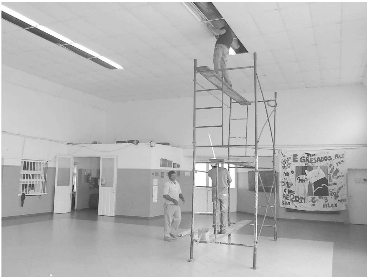
Vista de la ejecución de los trabajos que se realizan en el Salón de Usos Múltiples del establecimiento educativo. Foto De Sogós.
