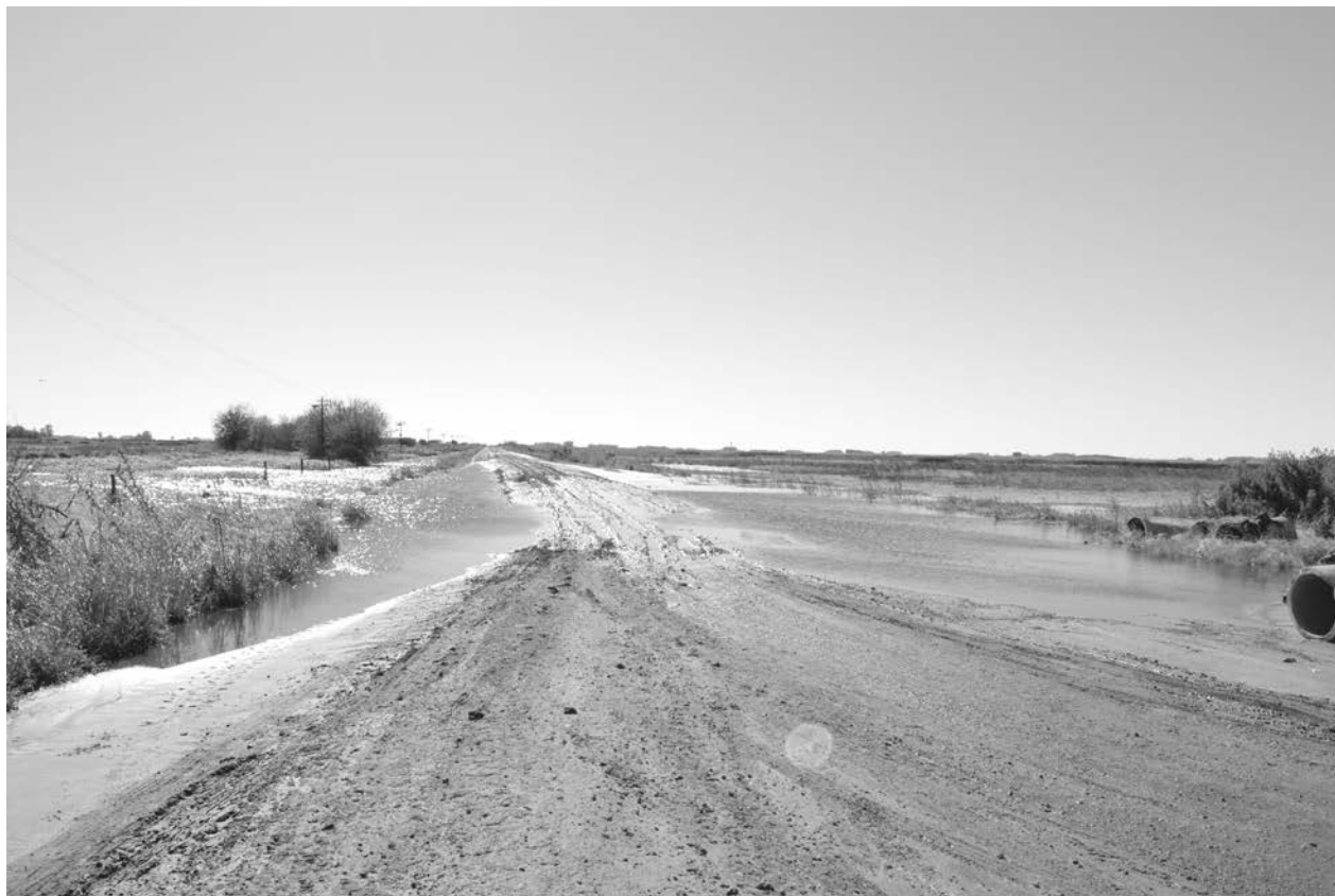
Imagen del intransitable camino que conduce a la localidad de El Tejar.
